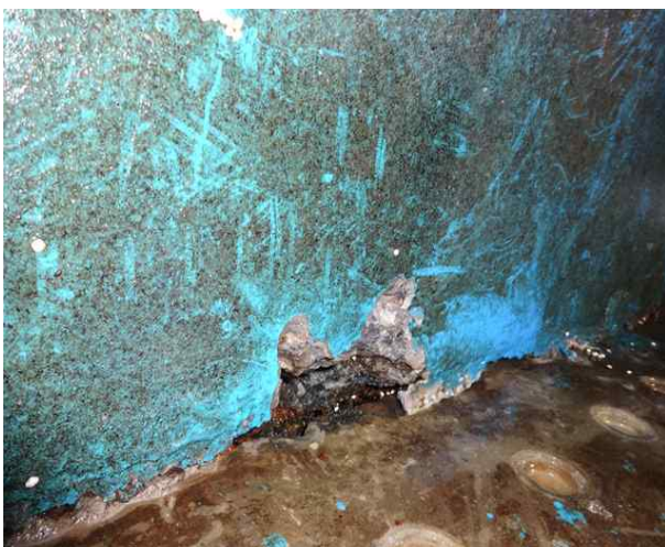
“E” 내부 벽체와 스트레이너 블록 연결부 박락 및 여재 유출 (A=3.0m×0.1m)
