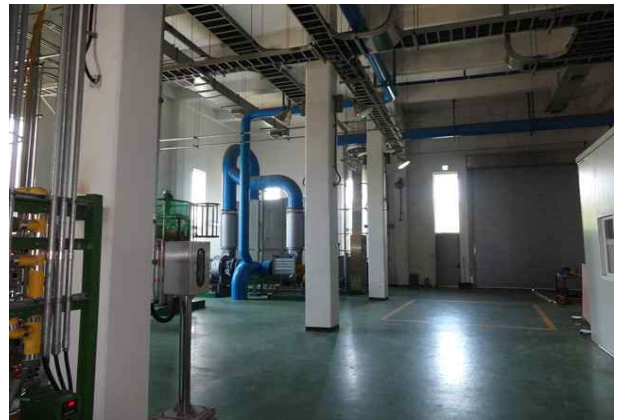
내부 약품 및 탈취기실 전경
