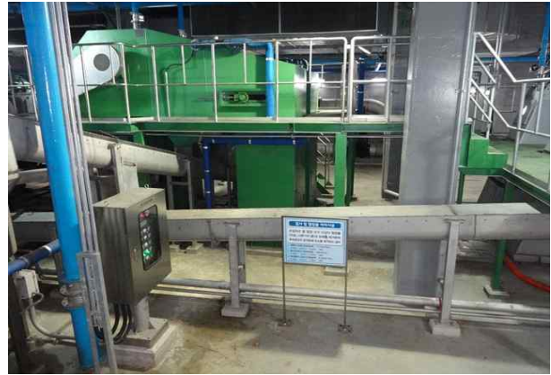
침사 및 협잡물 처리시설 전경
