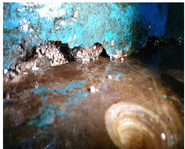
“E” 내부 벽체와 스트레이너 블록 연결부 박락 및 여재 유출 (A=3.0m×0.1m)
